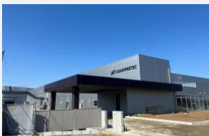
竣工が迫る坂東工場第2期
